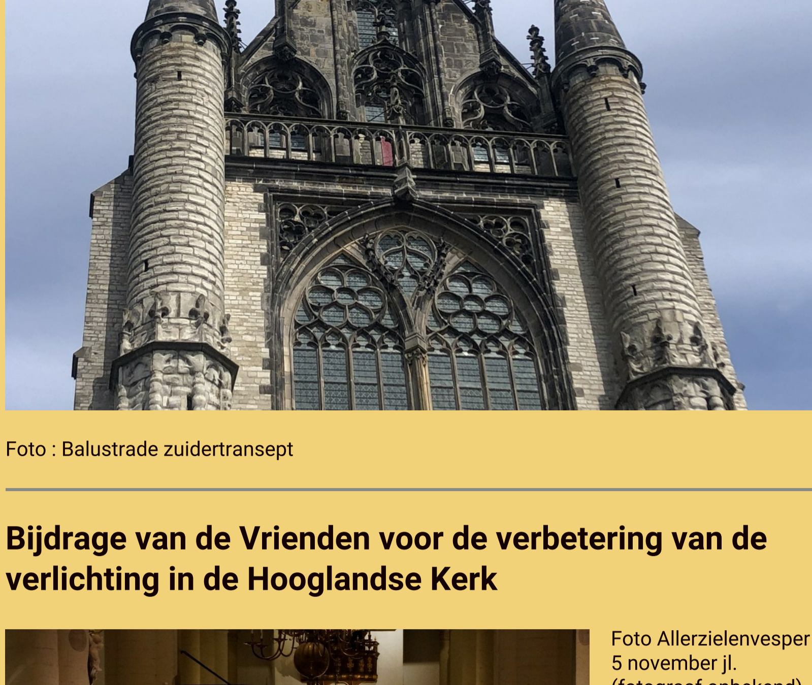
Foto : Balustrade zuidertransept
